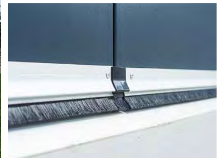
Detail spodního těsnění posuvných vrat
